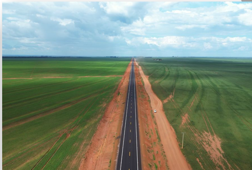
RODOVIA DO GARBUGIO - CAMPO VERDE
