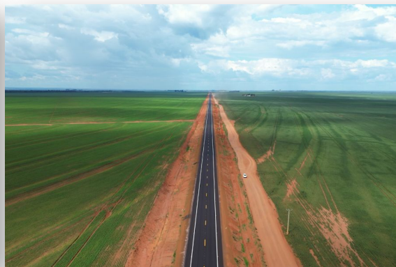
RODOVIA DO Garbugio CAMPO VERDE
